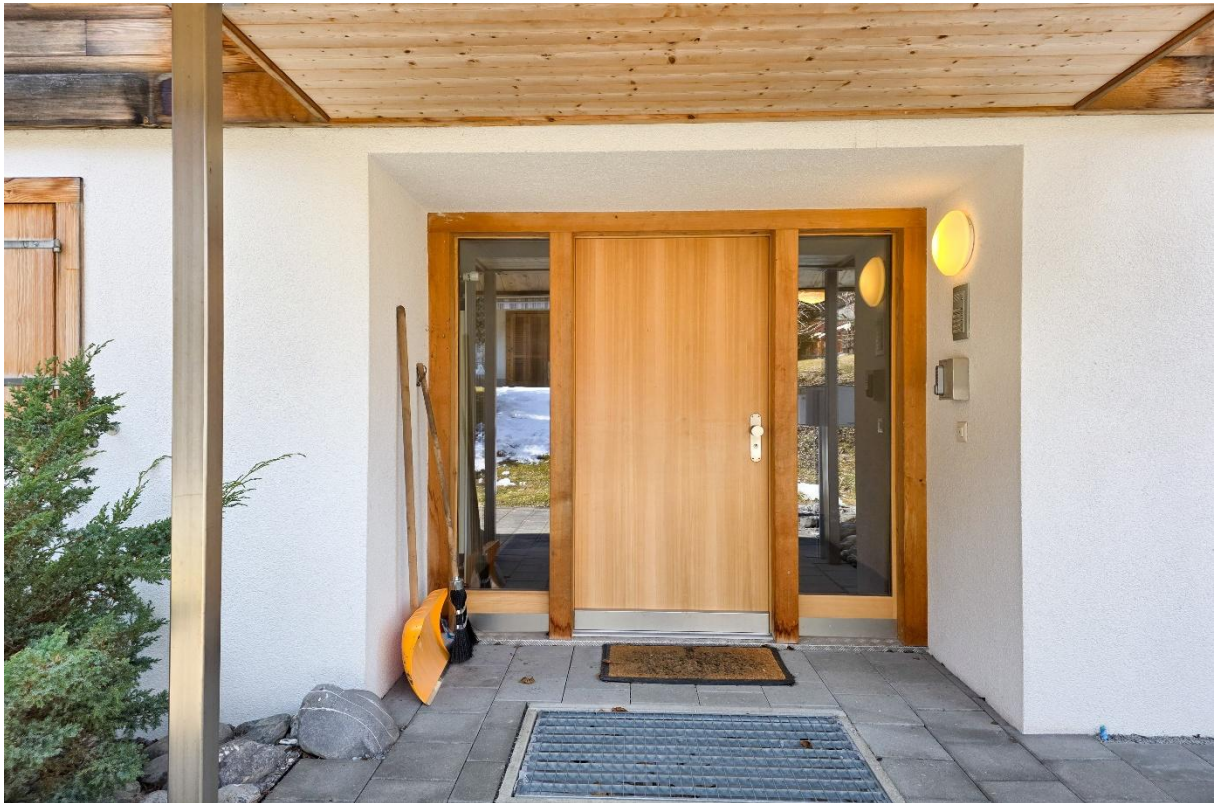
Der gedeckte Eingangsbereich in das Mehrfamilienhaus
