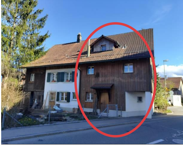
Nordfassade mit Garten und zwei Hauseingängen Hausteil West rechts (Mietobjekt), Hausteil Ost links
