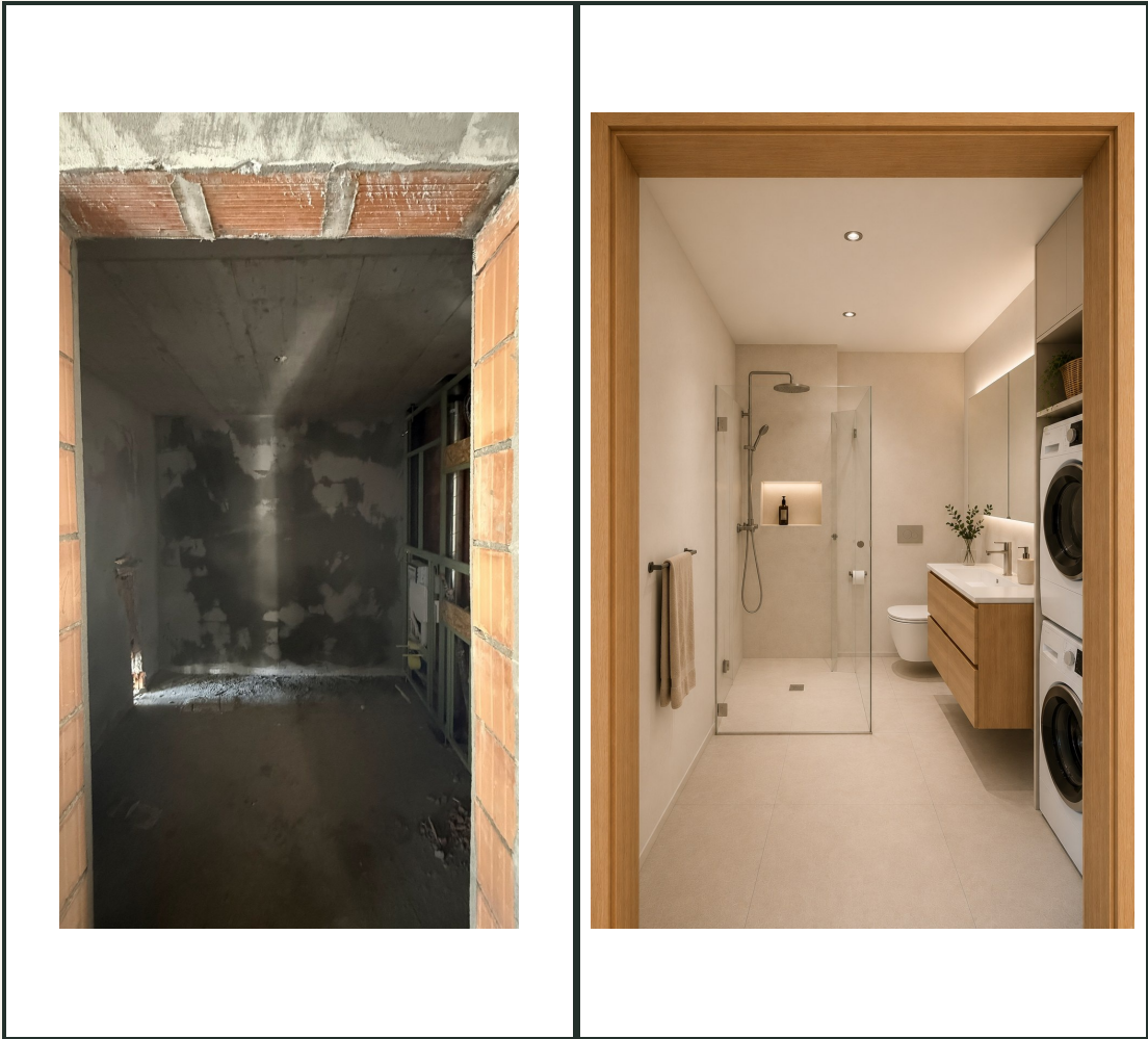
IST Rohbau, aktueller Bautenstand (Originalfoto)
