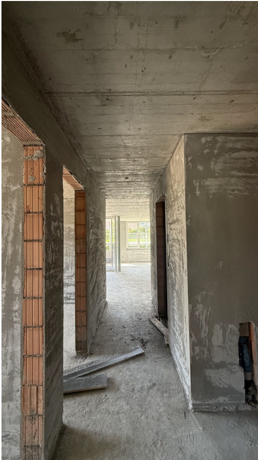
IST Rohbau, aktueller Bautenstand (Originalfoto)
