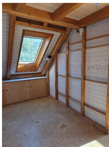
Dachgeschoss Home-Office Bild 1
