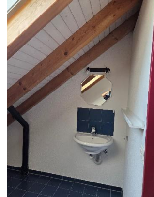
Dachgeschoss Bad Bild 2
