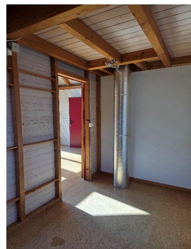
Dachgeschoss Home-Office Bild 2
