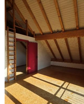
Dachgeschoss Wohn-&Schlafraum Bild 1
