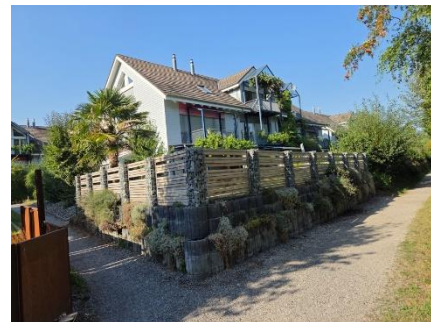
Aussen aus Südwest
