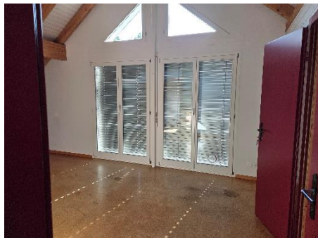
Dachgeschoss Wohn-&Schlafraum Bild 1
