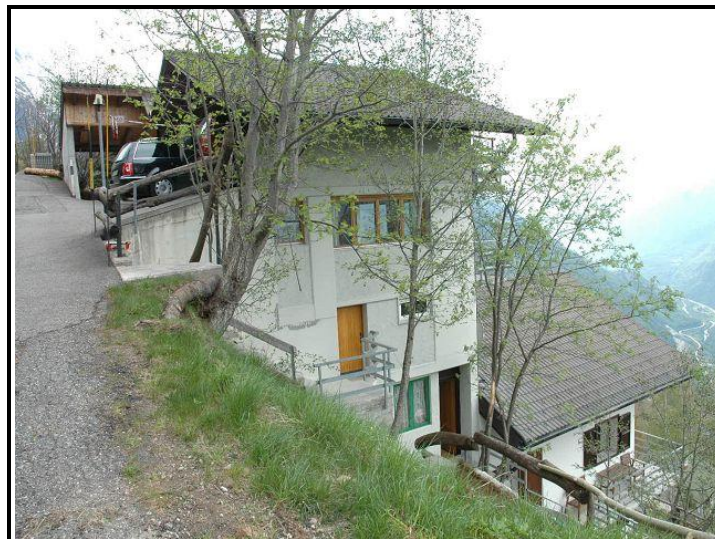
Facciata est / Westfassade
