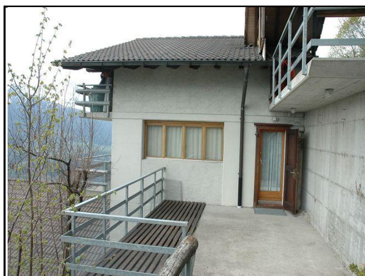
Terrazza sopra / Terrasse der Dachwohnung
