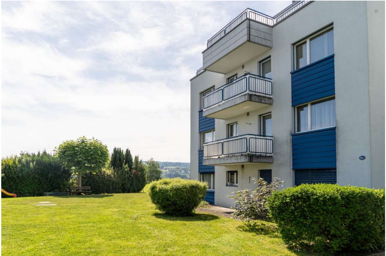
Überbauung Engelhof, Breitschachenstrasse 8c, Engelburg
