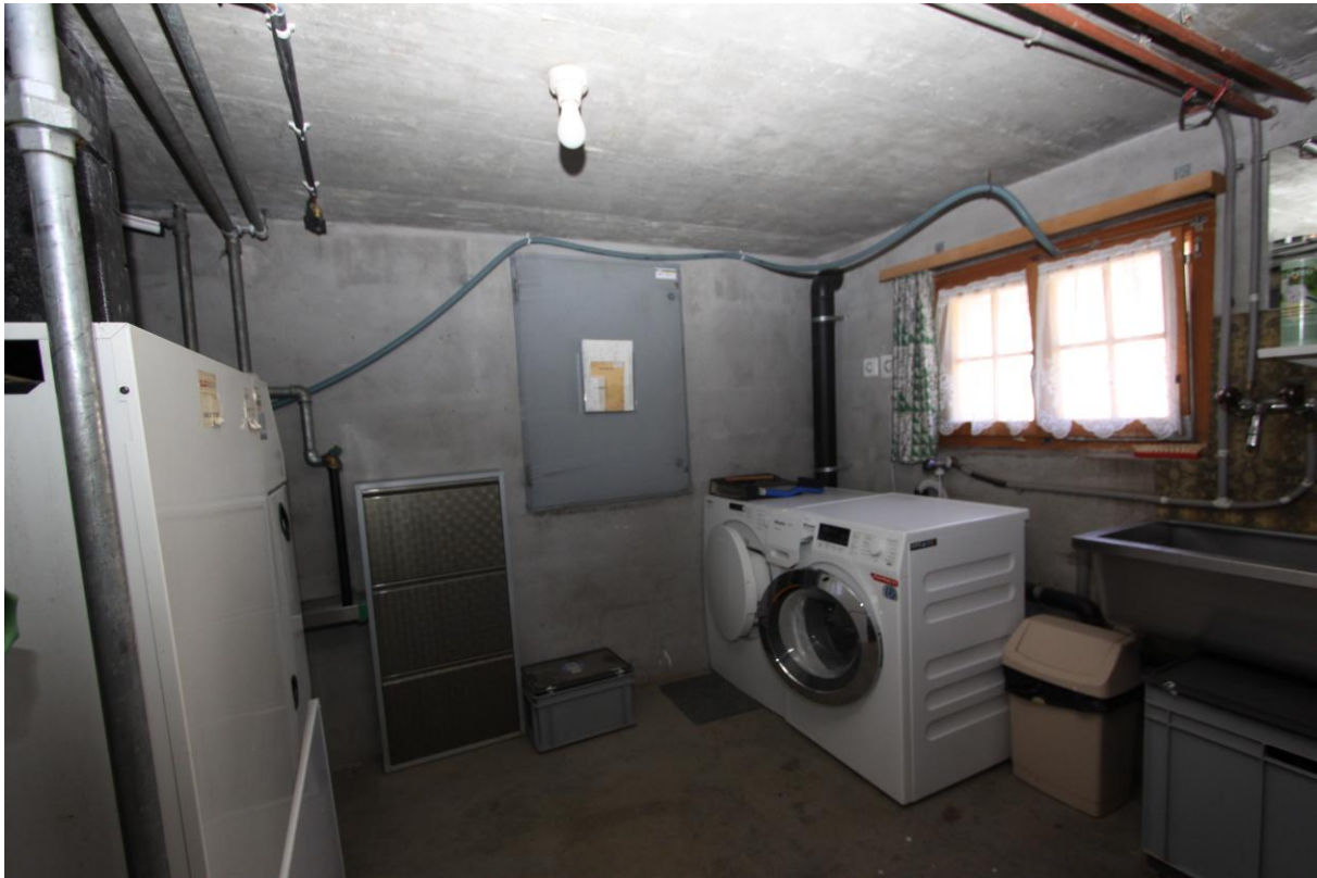
Wasch- und Heizraum
