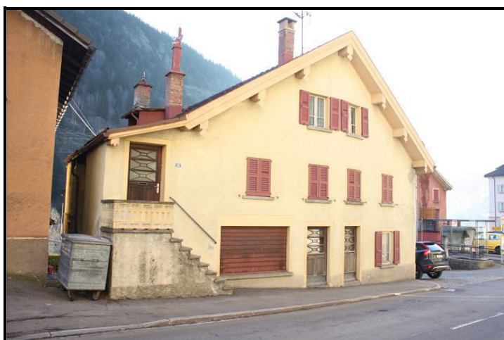
Facciata ovest / Westfassade
