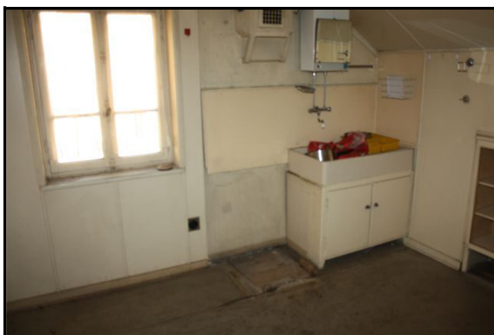
Cucina sotto tetto / Küche im Dachbereich
