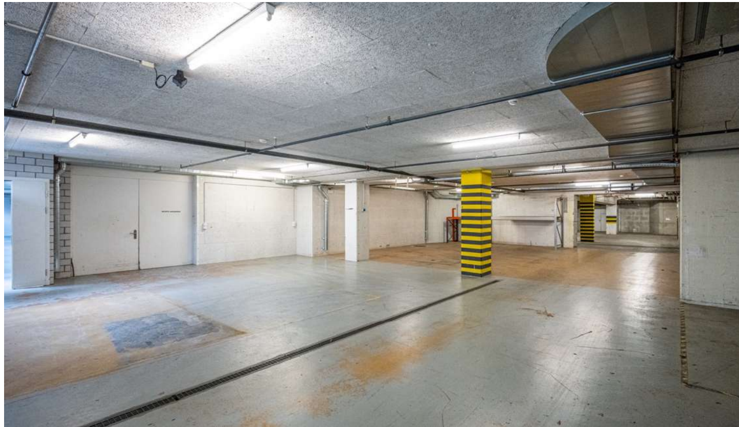
Anlieferung Gewerberaum Untergeschoss
