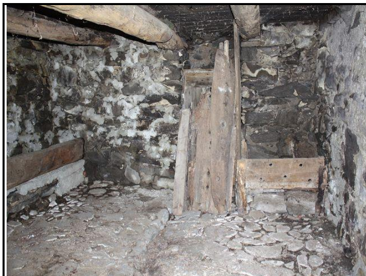
Locale sotto / unterer Raum
