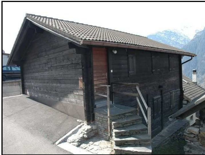
Vista verso nord-est / Blick nach Nord-Ost
