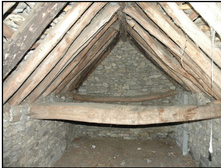
Sotto tetto / Dachgeschoss
