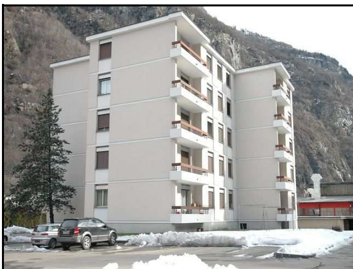
Facciata ovest / Westfassade
