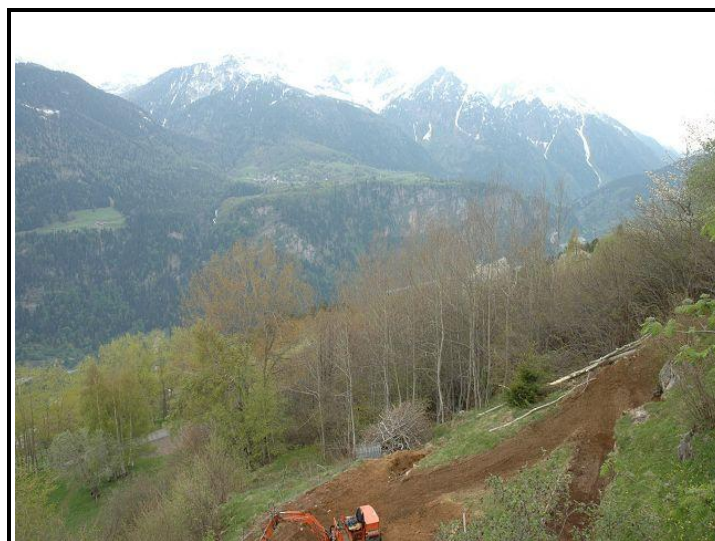
Vista verso nord-ovest / Blick nach Nord-Westen
