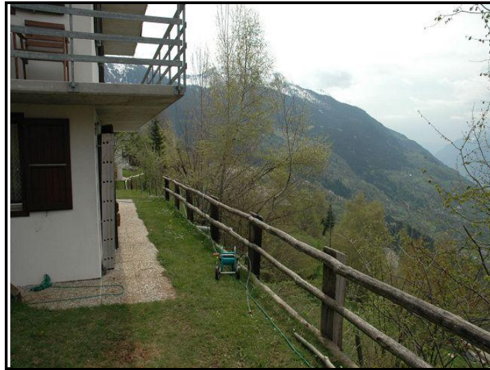
Cortile / Sitzplatz im Erdgeschoss
