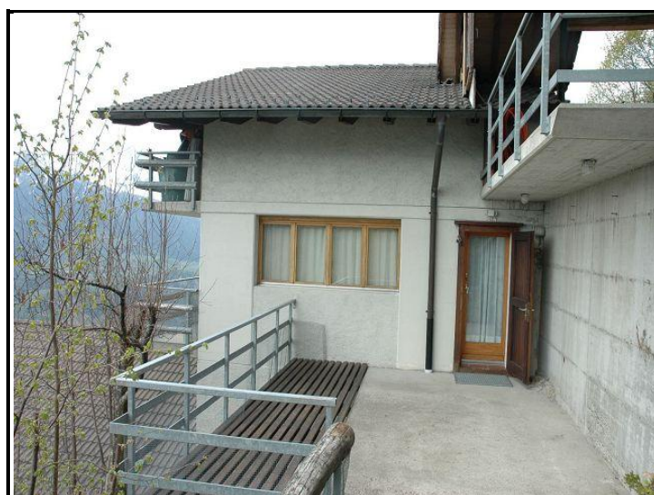
Terrazza sopra / Terrasse der Dachwohnung
