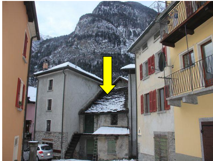
Blick zum Garagegebäude / Vista verso edificio del garage
