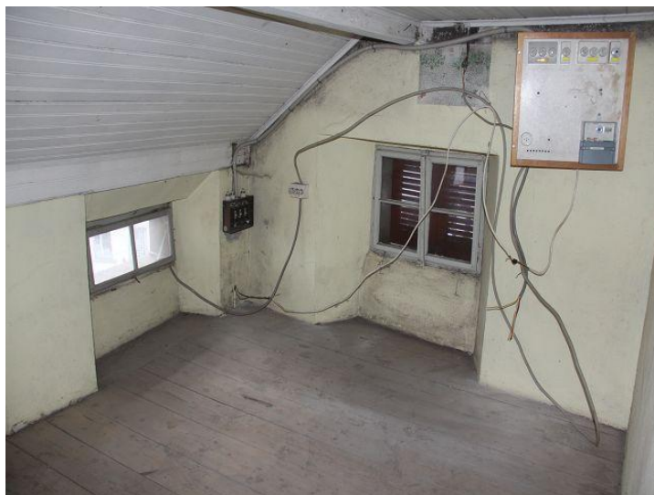
Dachzimmer / camera sotto tetto
