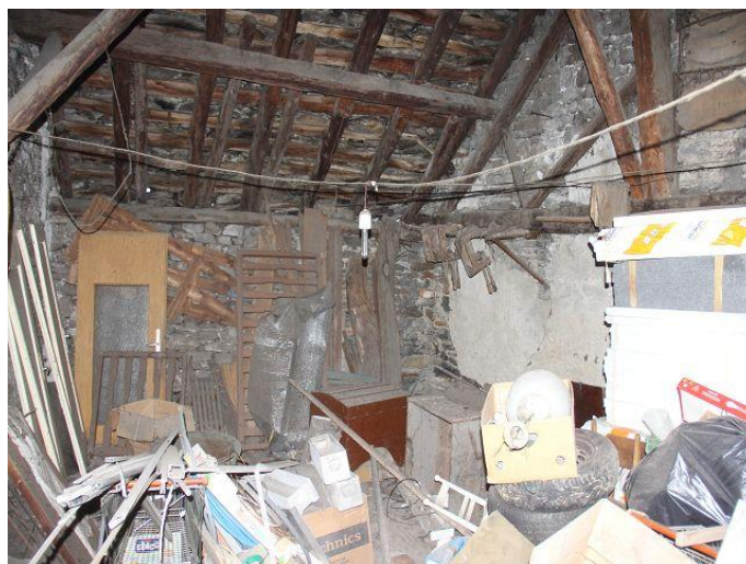
Dachraum der Garage / sotto tetto del garage
