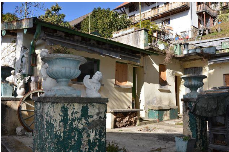
Nebengebäude / casa annessa
