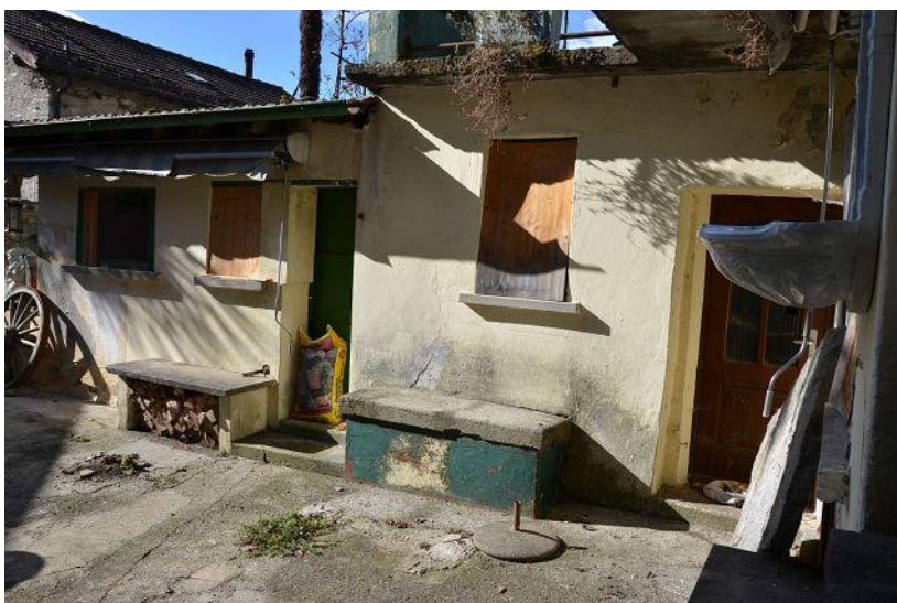
Nebengebäude / casa annessa
