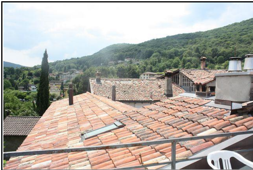
Vista sud / Südblick
