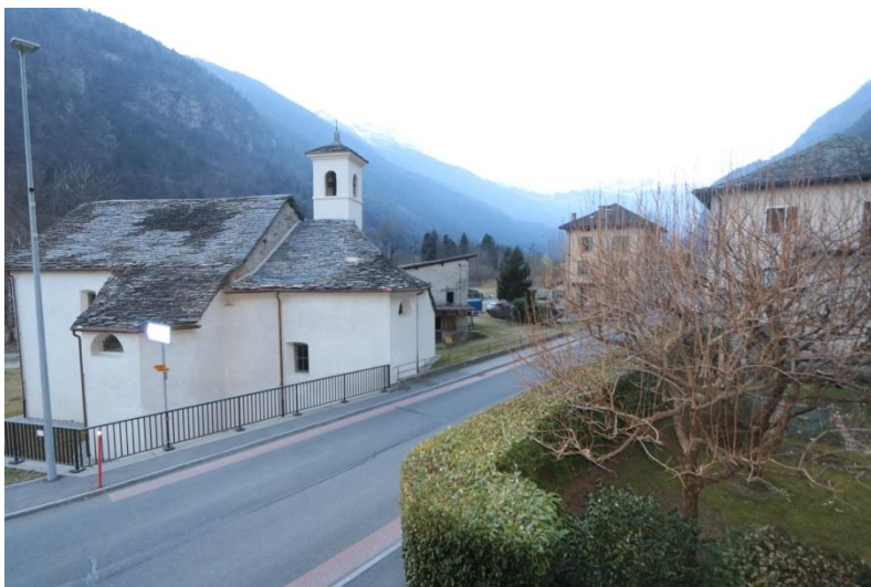
Blick nach Norden / vista nord
