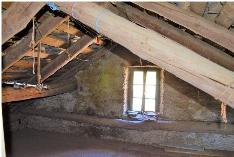
Dachraum / sotto tetto
