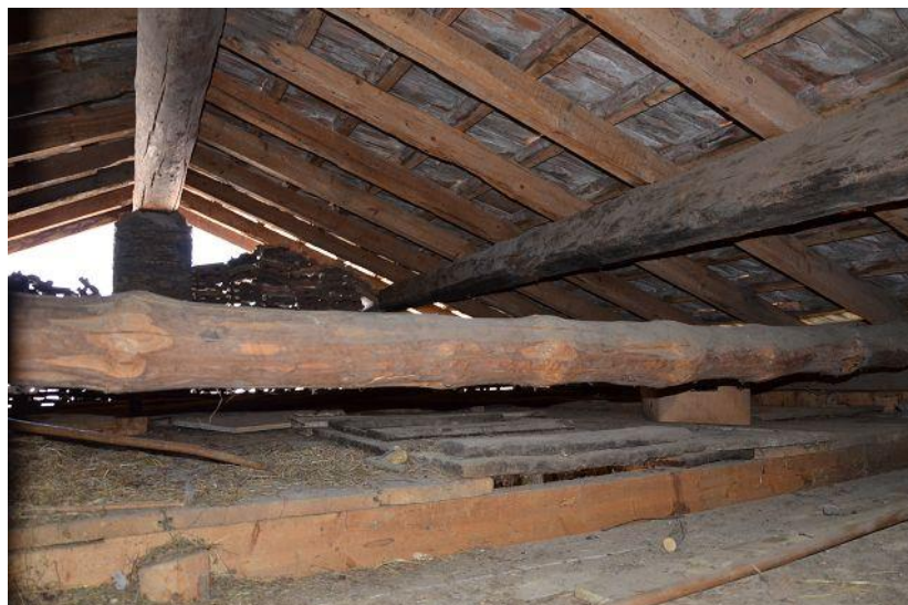
Dachraum Rustico / sottotetto rustico
