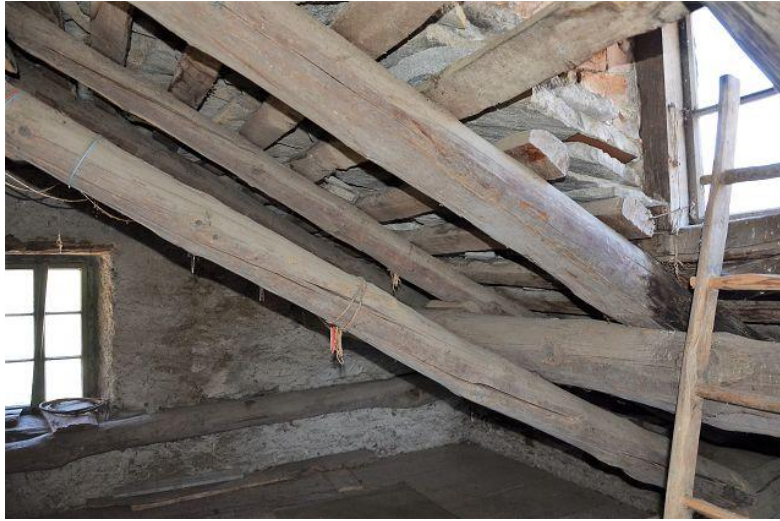
Dachraum / sotto tetto
