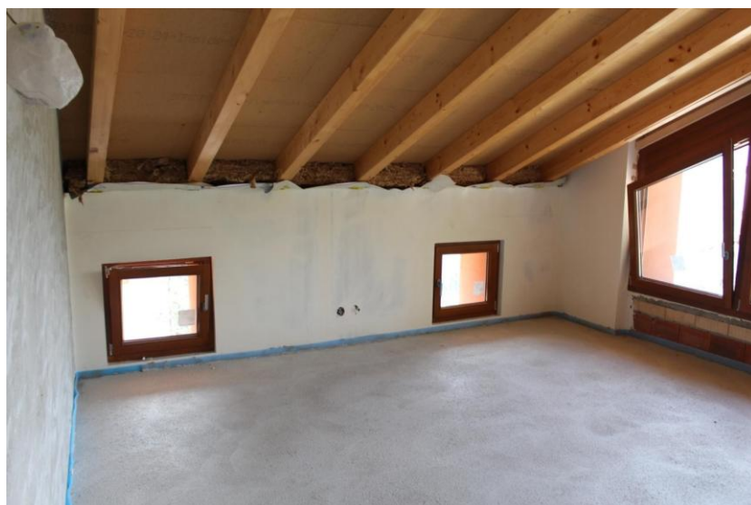
Dachzimmer / camera sotto tetto
