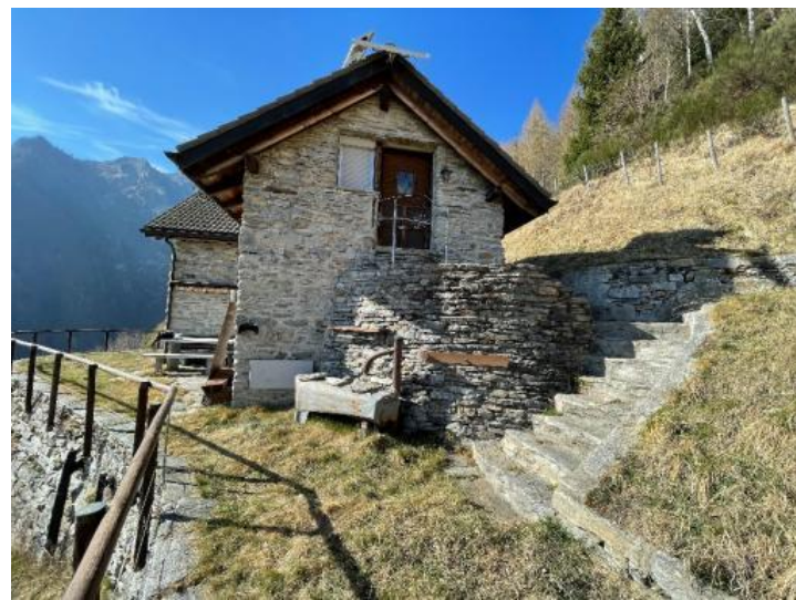
Eingang zum OG / l'ingresso al piano sopra
