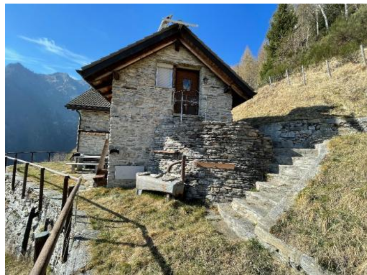
Eingang zum OG / l'ingresso al piano sopra
