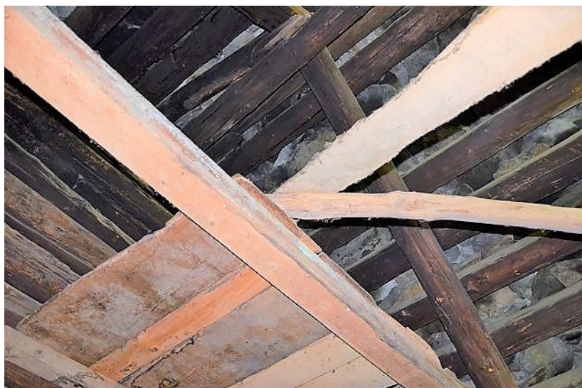
Dachuntersicht / sotto tetto
