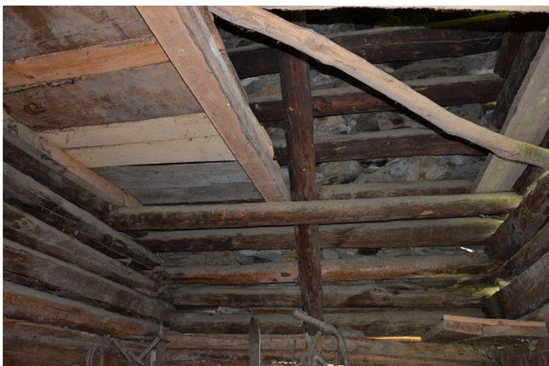
Dachuntersicht / sotto tetto
