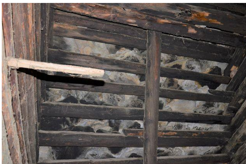
Dachuntersicht / sotto tetto
