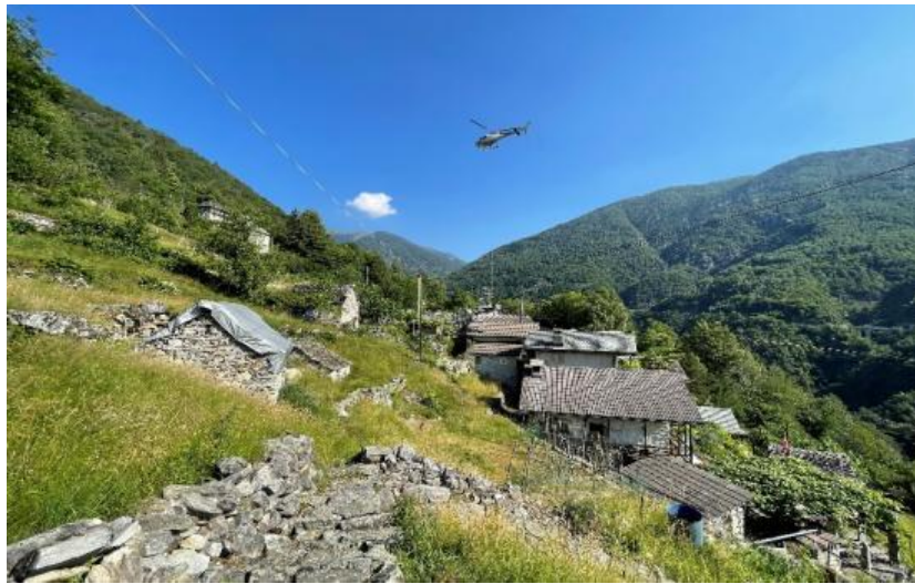
Rustico mit Grundstück / i rustici con terreno
