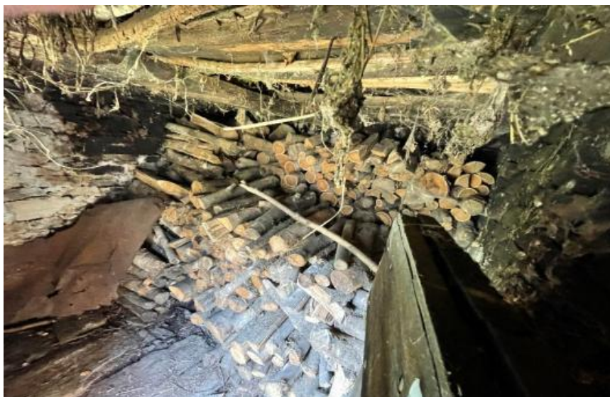
im Erdgeschoss / al piano terra
