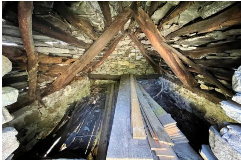
Dachgeschoss / sotto tetto
