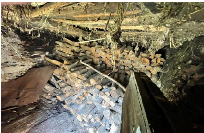
im Erdgeschoss / al piano terra
