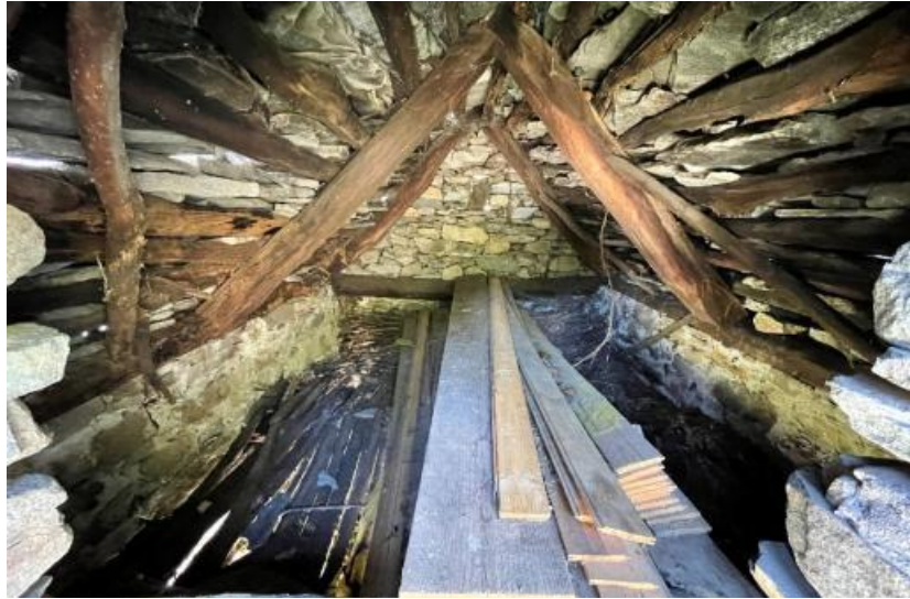
Dachgeschoss / sotto tetto
