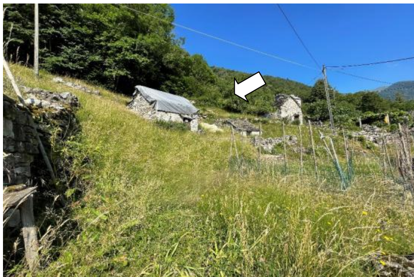
Rustico mit Grundstück / i rustici con terreno
