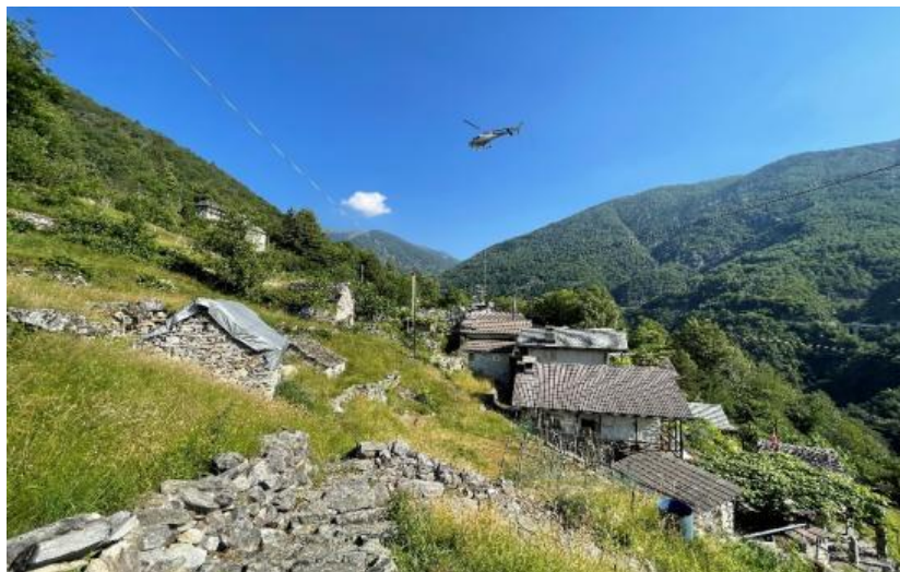
Rustico mit Grundstück / i rustici con terreno
