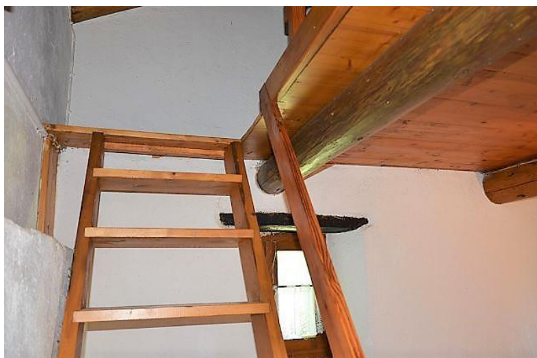
Treppe zum Hochgeschoss / scala al soppalco
