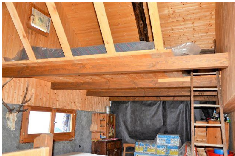
Dachraum / camera sotto tetto
