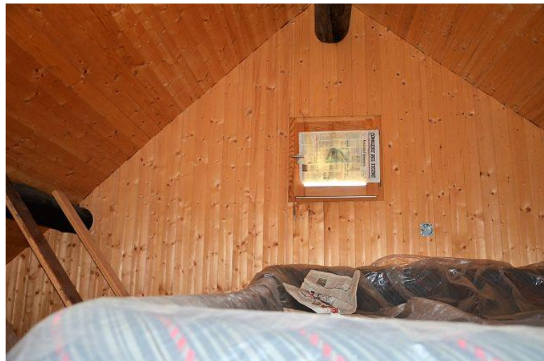
Dachraum / camera sotto tetto
