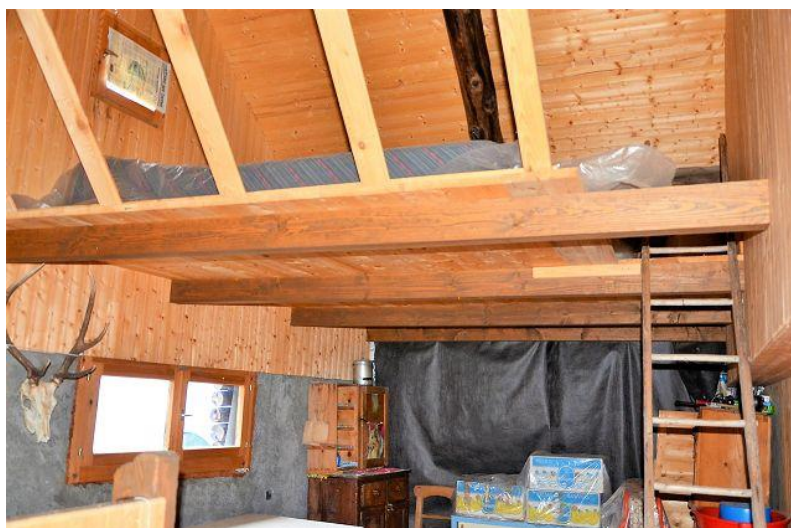
Dachraum / camera sotto tetto
