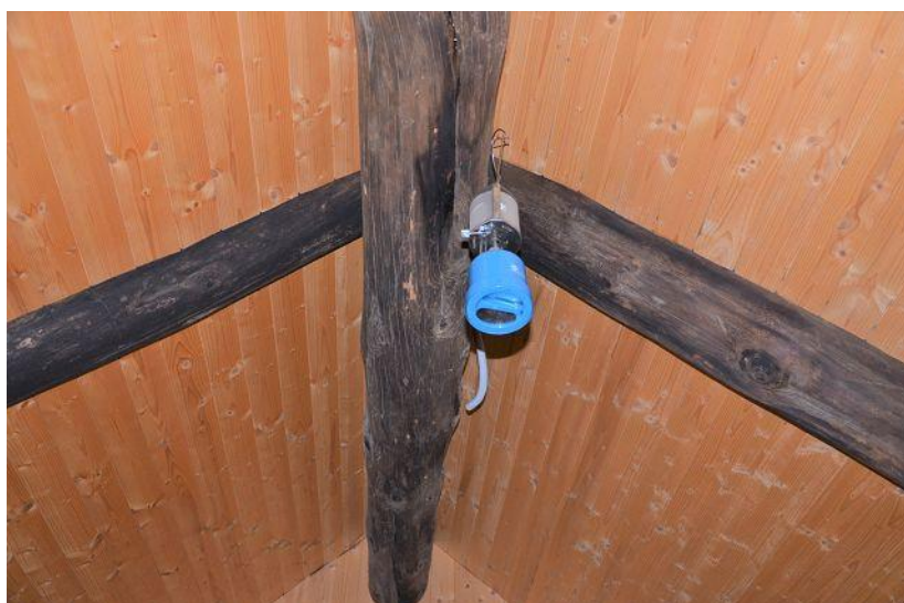
Dachkonstruktion / sotto tetto
