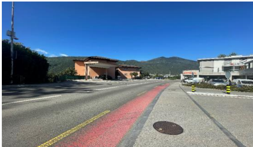
Die Kantonsstraße / La strada cantonale
