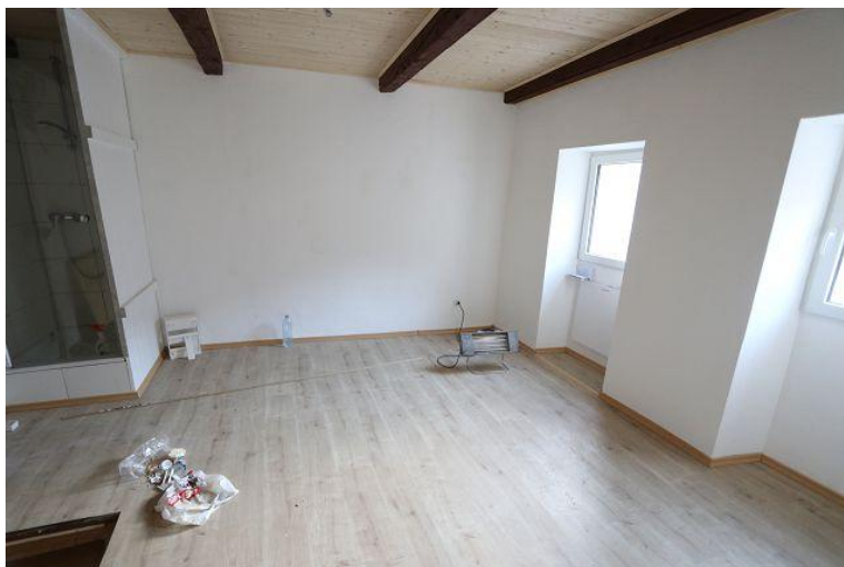
Zimmer mit Dusche im 2. Obergeschoss / camera con doccia nel secondo piano
