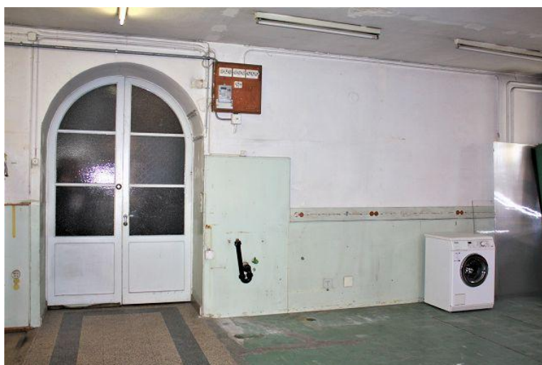
Waschküche EG / lavanderia PT
