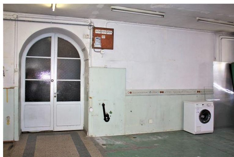
Waschküche EG / lavanderia PT
