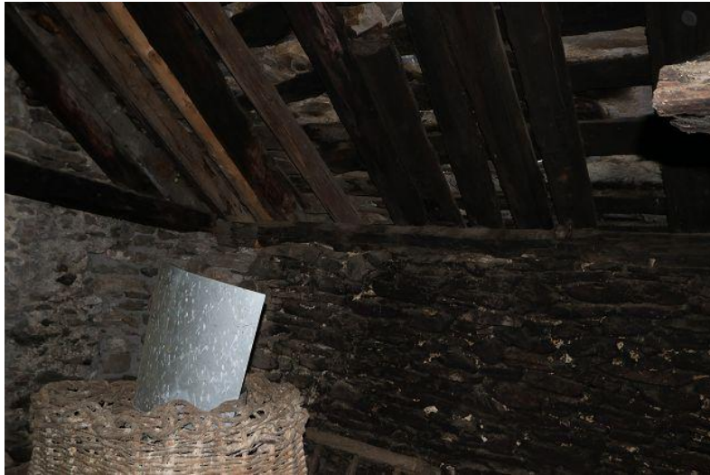
Unterdach /sotto tetto
