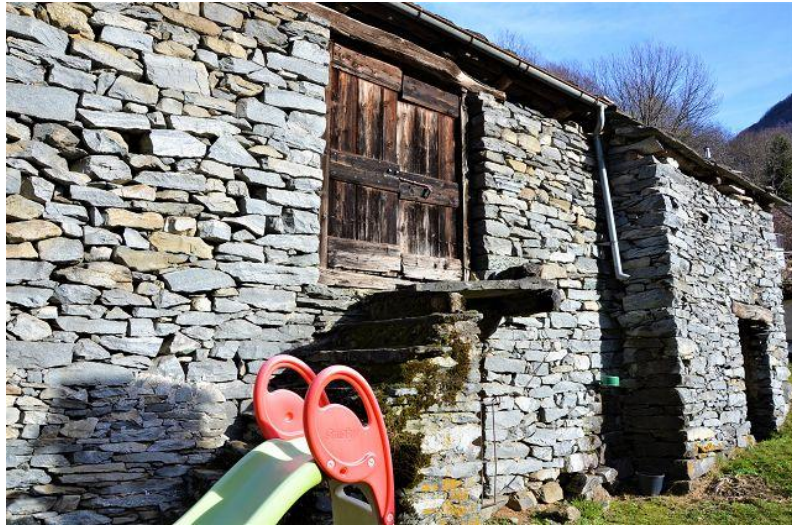
Seitenansicht Rustico / lato rustici
