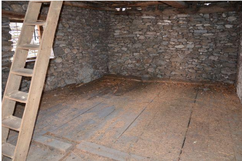
Innenbereich 1. OG / interni PP
