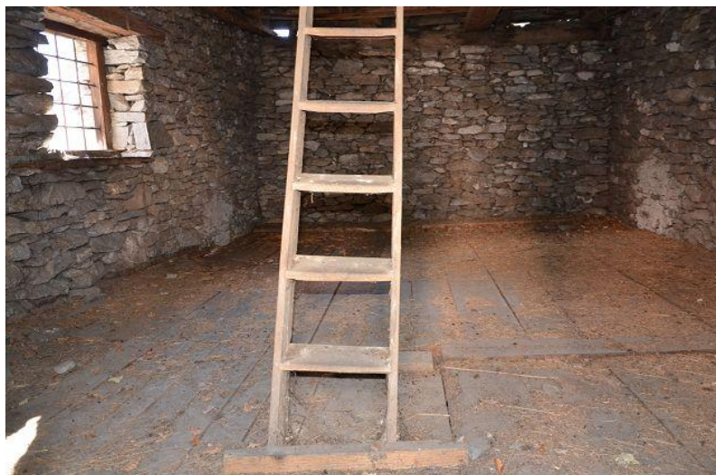
Innenbereich 1. OG / interni PP
