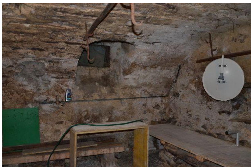
Keller Haus Ost / cantina casa est
