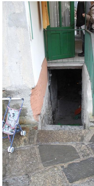
Kellerräume, Waschküche und Ansicht ● cantine, lavanderia e la casa
