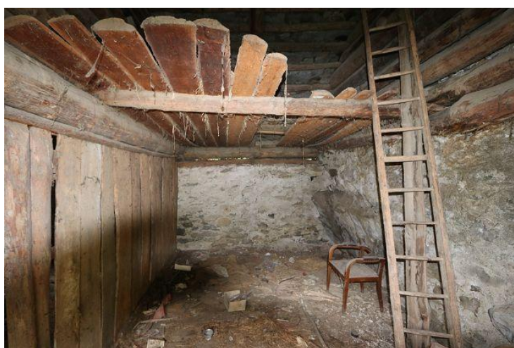
Innenraum 1. OG / interno primo piano
