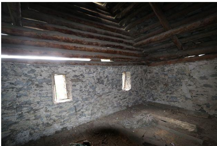
Innenraum 1. OG / interno primo piano
