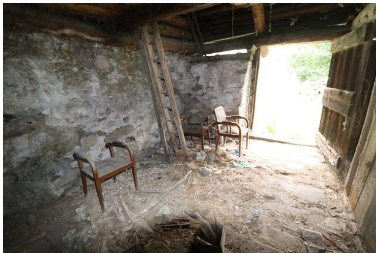
Innenraum 1. OG / interno primo piano
