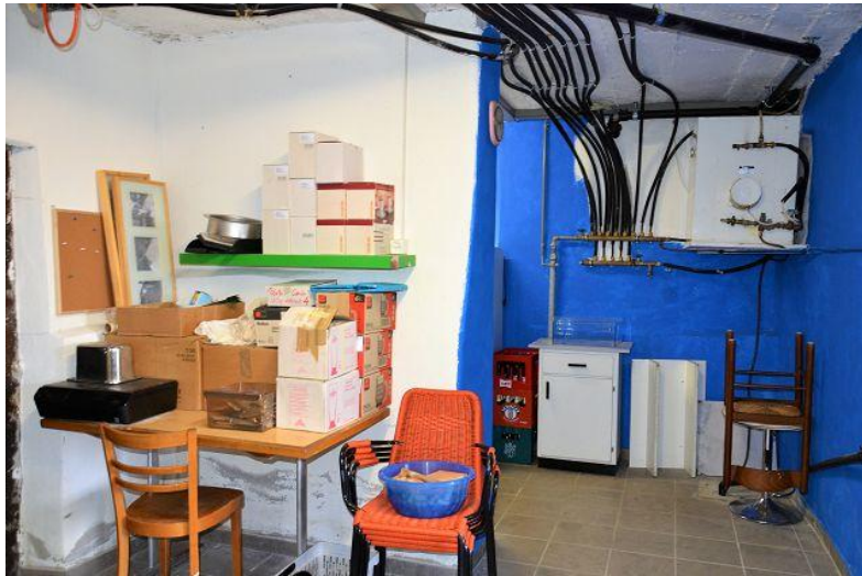
Warenraum EG / deposito PT
