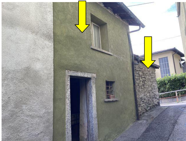
Haus zum Ausbauen Grundstück 206 / casa da ristrutturare map. 206
