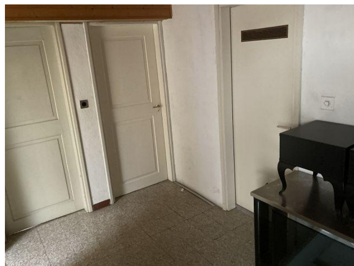
Dachvorraum / Atrio nella mansarda
