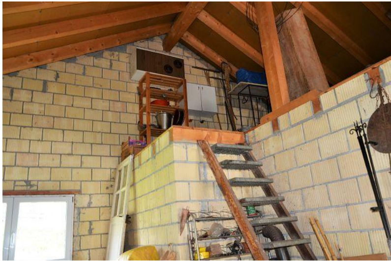
Fussboden Nebengebäude / annessi solaio
