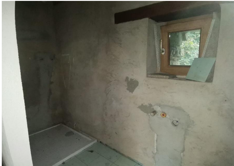
WC – Dusche / WC – doccia
