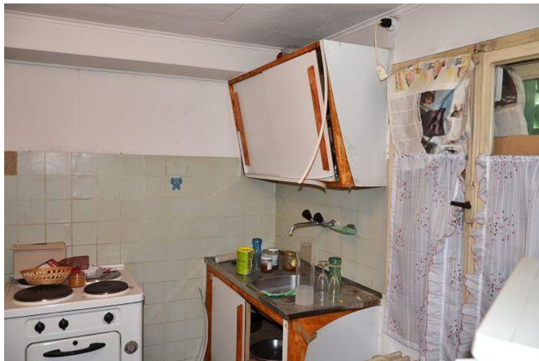
Küche im Dachgeschoss / cucina nella mansarda
