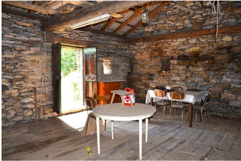
Innenbereich 1. OG / interni PP
