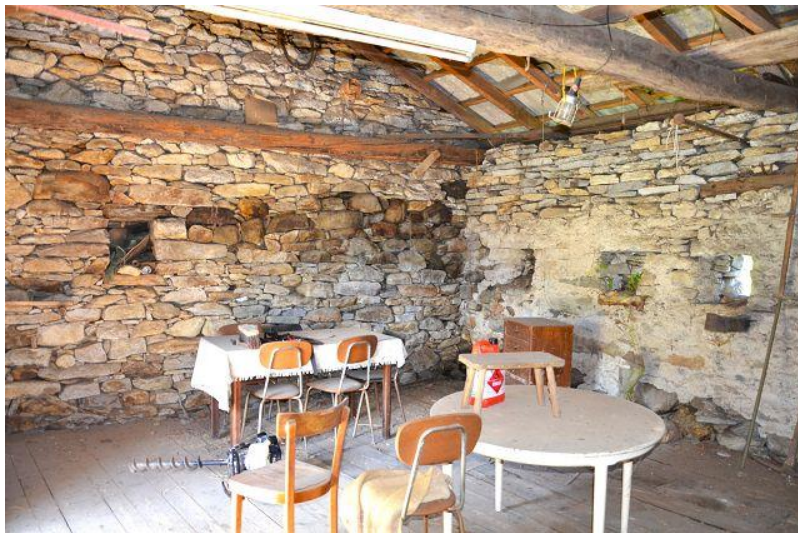
Innenbereich 1. OG / interni PP
