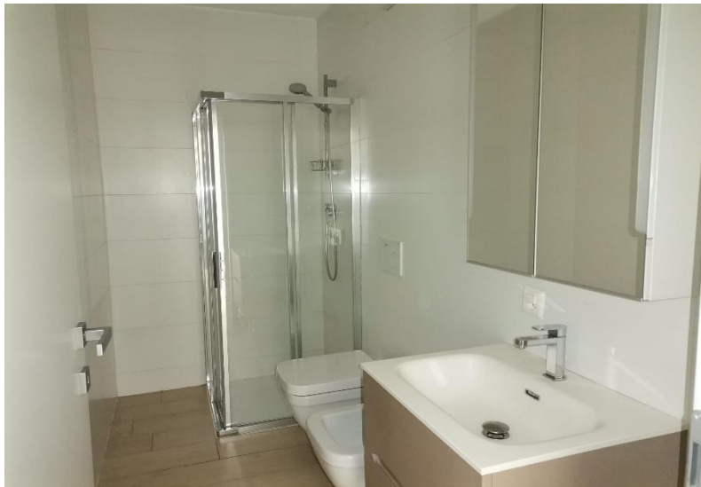
WC – Dusche / WC – doccia
